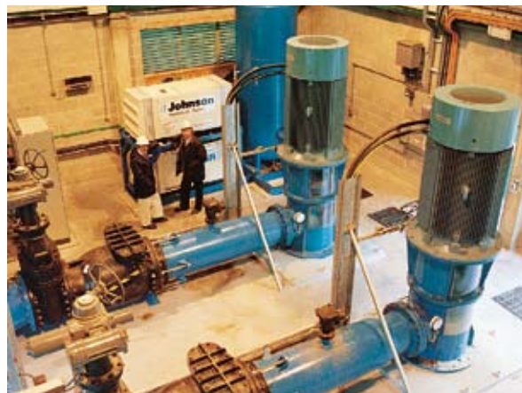
Привод 12-импульсного преобразователя частоты компании ABB установлен в насосах закачки речной воды на рафинадном заводе Tate and Lyle на реке Темзе.
