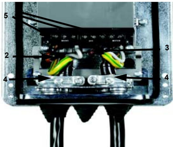
3. Зачистите оболочку кабеля электродвигателя на длину, необходимую для скрутки экрана кабеля. Для снижения паразитного излучения длина скрученной части кабеля должна быть минимальной. Зачистите отдельные жилы кабеля.
